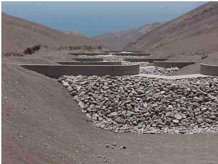
**Figura 7.** Pozas decantadoras construidas en las cercanías de la ciudad de Antofagasta, Chile. Vista desde aguas arriba. (Imagen tomada de Montserrat, 2005)
