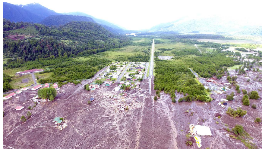
Fotos del dron despues de la inundación.
