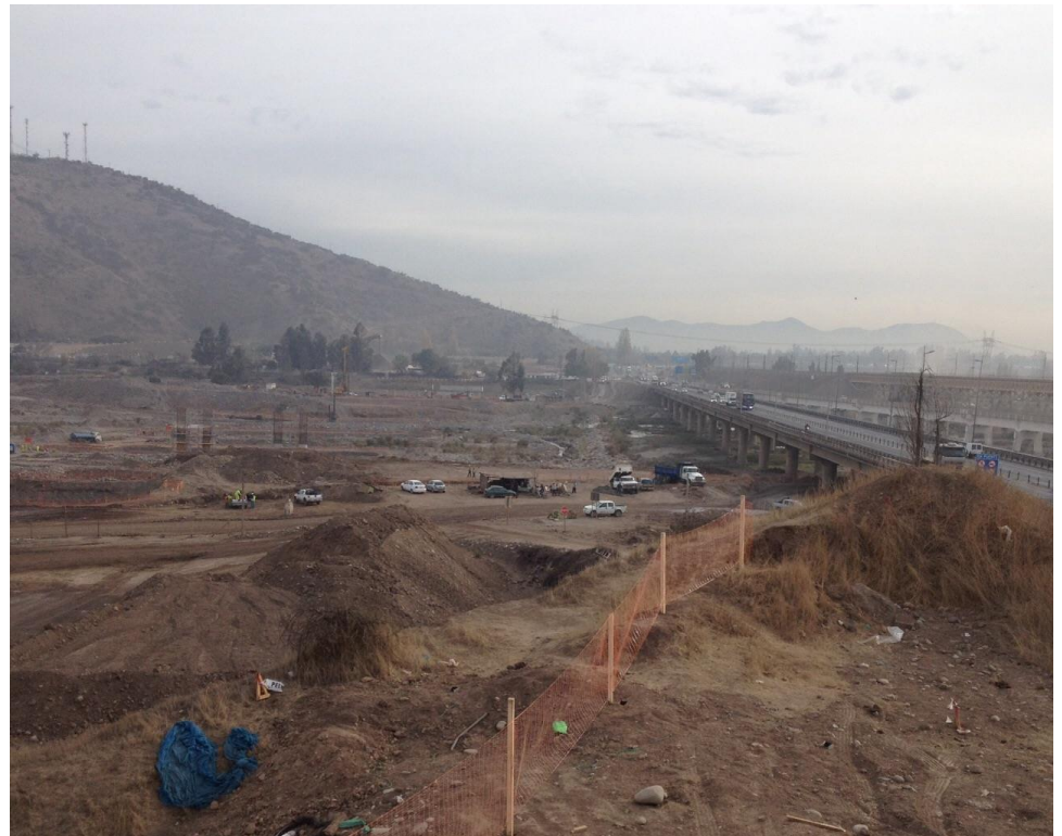
FOTO SECTOR PUENTE MAIPO Y MURO GUARDARRADIER.
