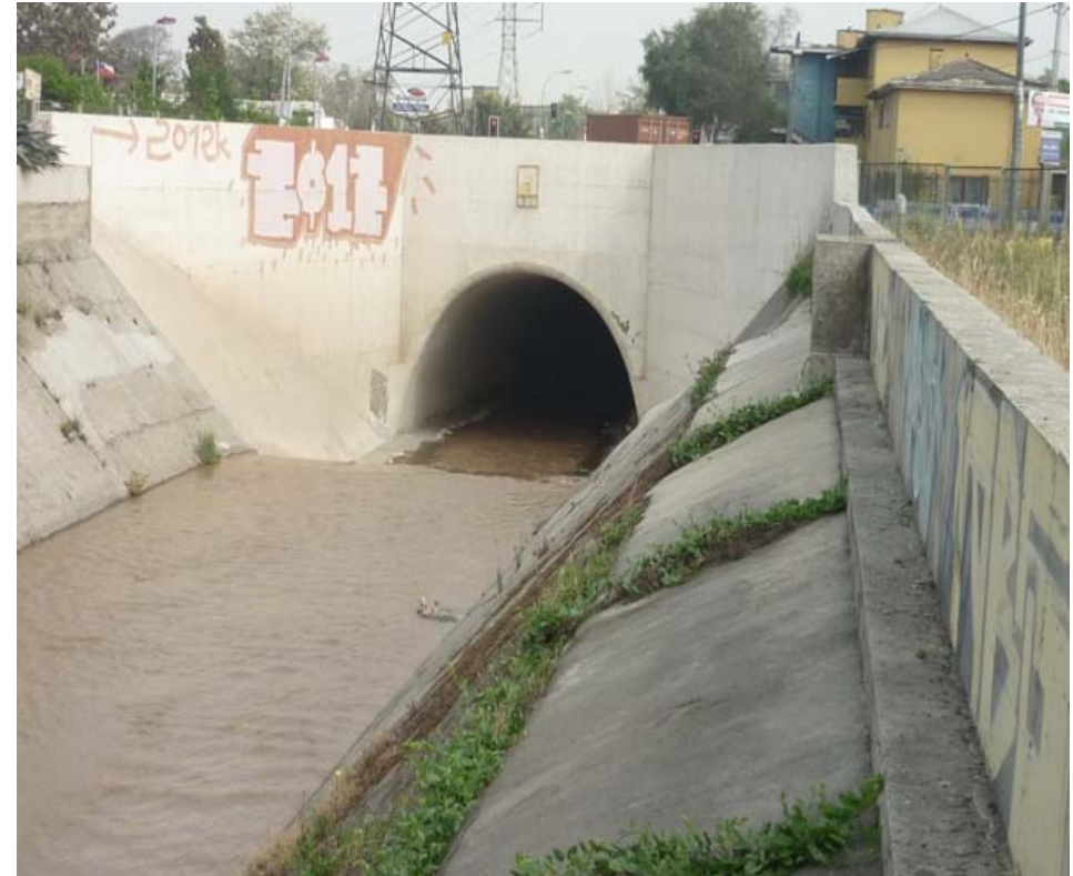
FOTO INICIO BOVEDA ZANJÓN DE LA AGUADA
